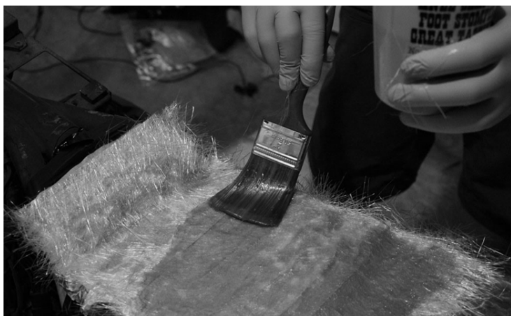
تصویر ۵ - ۱ استفاده از رزین برای تعمیر قایق
